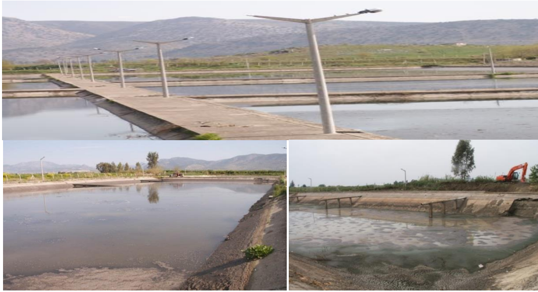
Şekil 5. Kozan ilçesi stabilizasyon ve anaerobik havuzları (uygulama yapılan)
