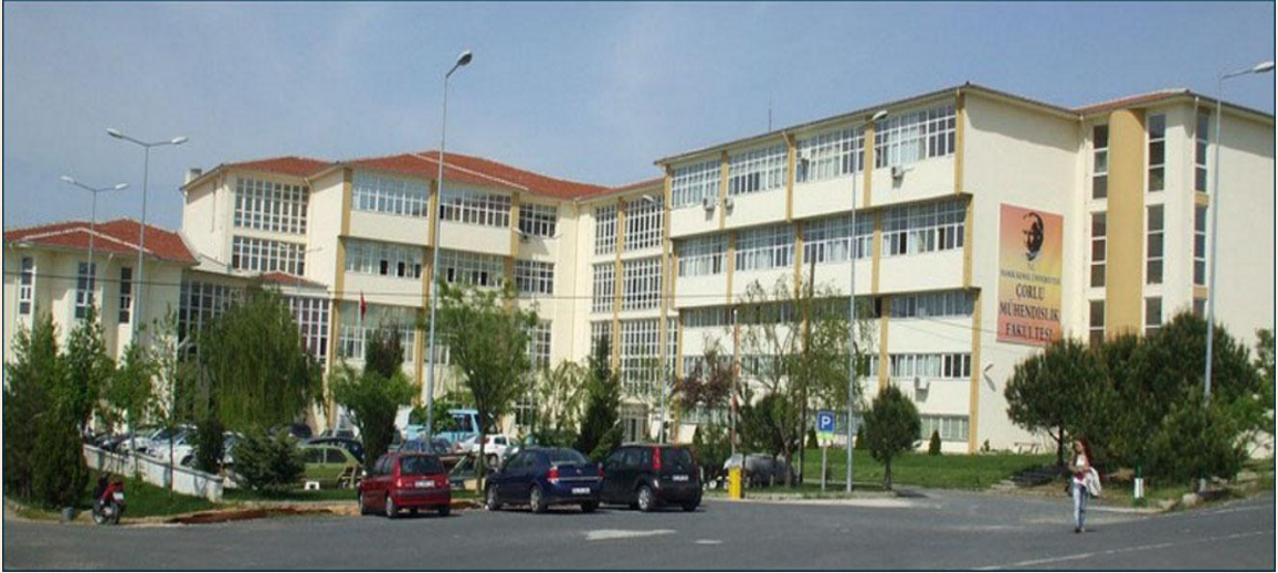
Resim 9: Çorlu Mühendislik Fakültesi Dekanlık Binası
